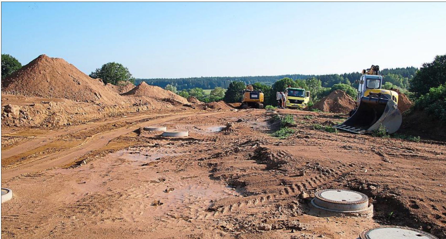
Mit reichlich Geld in der Kasse kann Rettenbach Erschließungsarbeiten wie hier im Neubaugebiet „Kapellenfeld“ weiterhin zuversichtlich in Angriff nehmen – vorausgesetzt die Konjunktur bricht nicht ein. Foto: Beiderbeck
